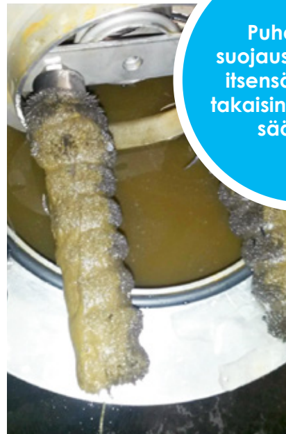
Käyttöönottopuhdistuksessa käytettyyn suodatinmagneettiin on tarttunut uuteen putkistoon jääneitä suojarasvoja.
